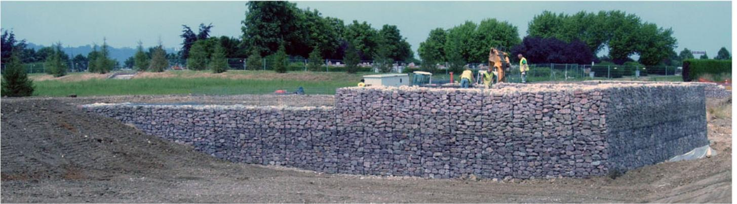
La solution initiale en double torsion imposait de plier et découper des cages préfabriquées. Les panneaux électrosoudés trapézoïdaux ont permis de réaliser très facilement le changement de fruit du parement (6°). Les parements parallèles à la voie rapide sont inclinés de 6° alors que les autres ouvrages (murs en retour) sont verticaux
